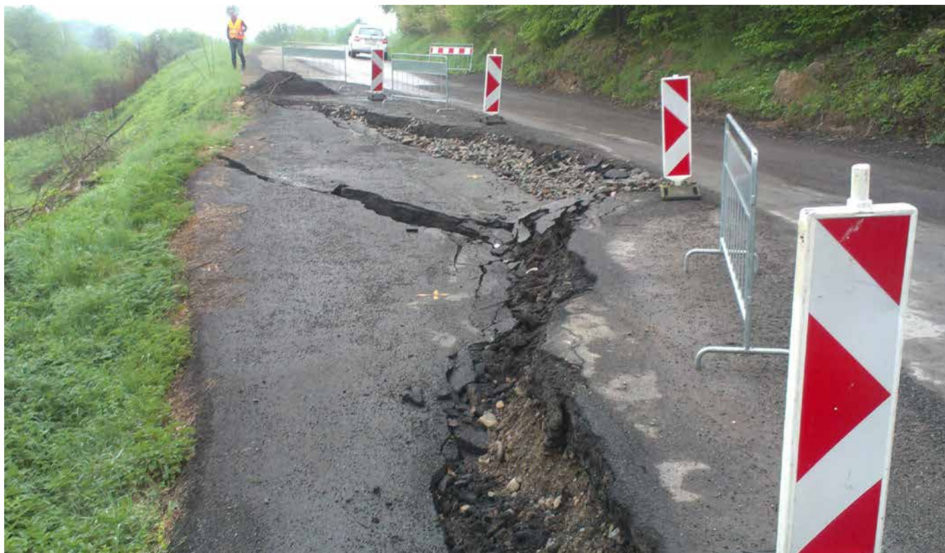
Obr. 3 Príklad úpravy zosuvu na ceste III. triedy (nevhodné riešenie za málo peňazí)
