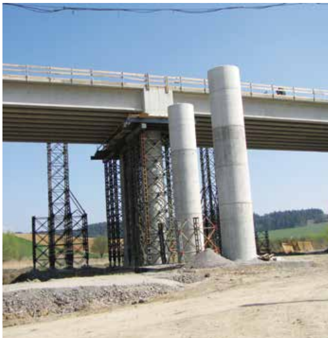
Obr. 4 Príklad zmeny hydrogeologických podmienok – podpery mosta SO 206-00 na úseku D1 Hričovské Podhradie – Lietavská Lúčka založené v navrhovanom zaplavnom území
